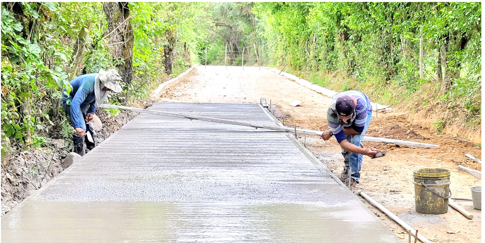
Con maquinaria del municipio se hace el mantenimiento de las vías de la Vereda Agua Caliente y Tambillo, además con sus materiales se realiza la pavimentación en Placa Huella.
