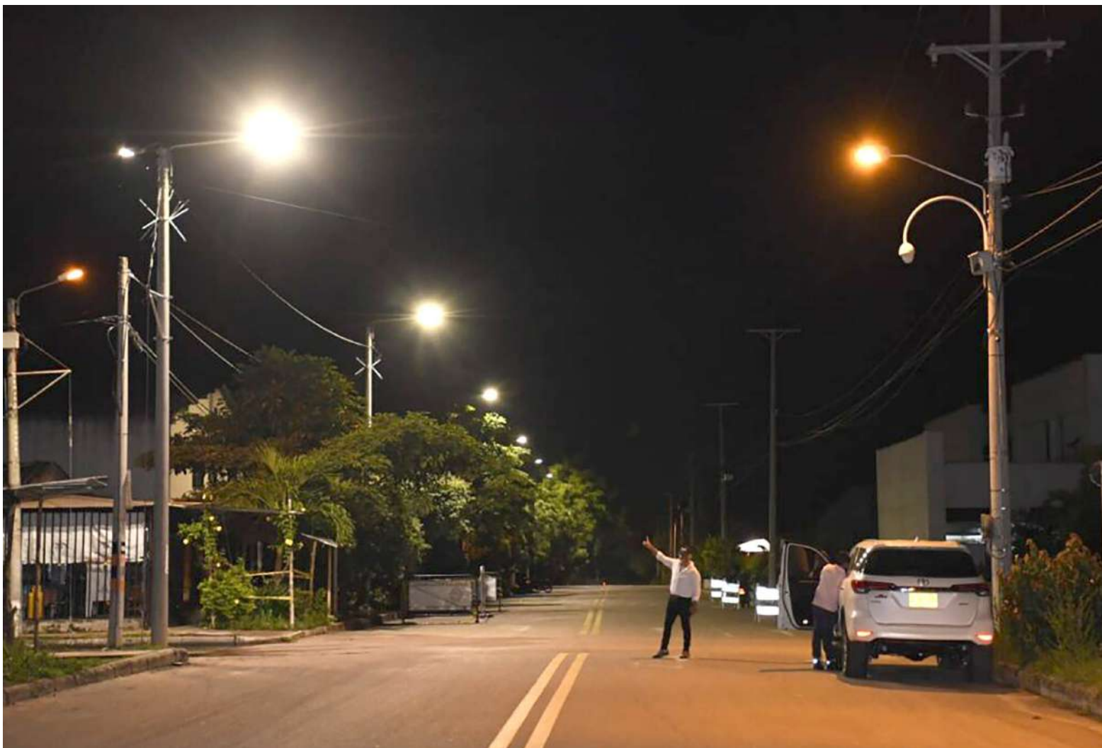
Ya se cumplió con el objetivo de la modernización al 31 de diciembre el cual era instalar 38.646 luminarias.
