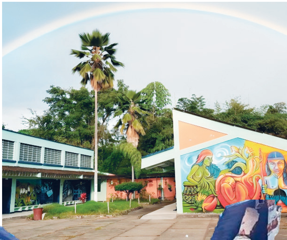
Uno de los colegios que necesita adecuación en infraestructura es el Juan XXIII, en el casco urbano.
