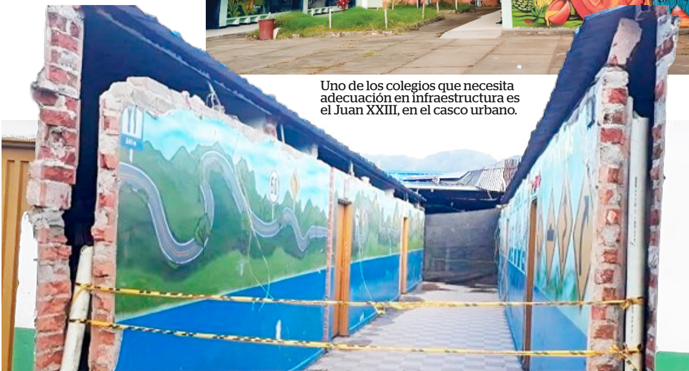
En la sede Herminia hubo que desmontar varias secciones para evitar afectar a 250 estudiantes.
