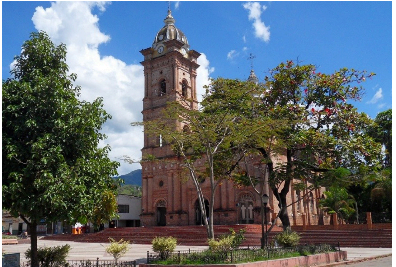
Lo que se evidenció es que la administración no hizo la suficiente vigilancia en la asignación de los permisos de uso del suelo.
