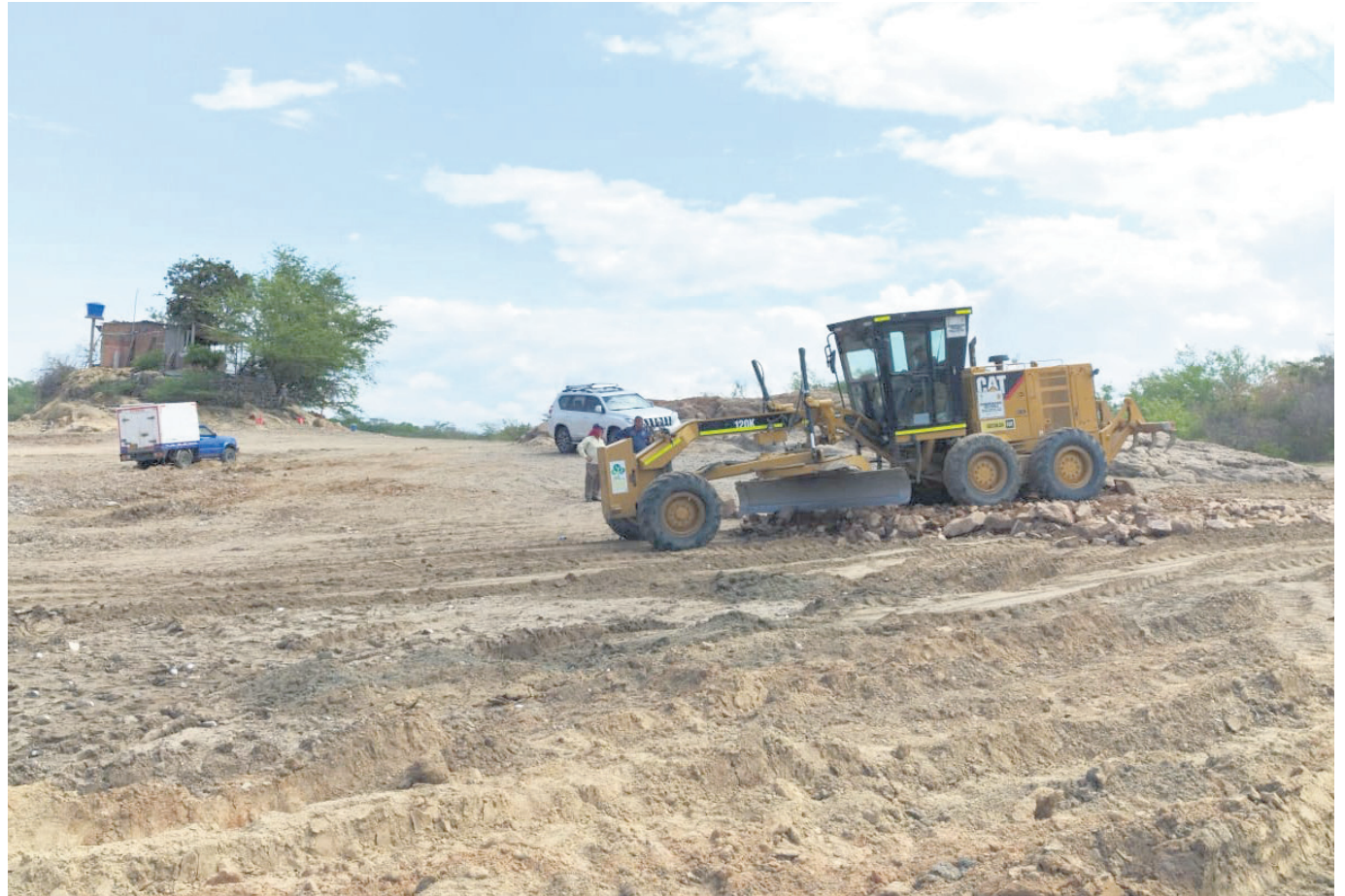
La Gobernación del Huila envió maquinaria amarilla para restaurar los puertos, asegurando el acceso de alimentos y la salida de la producción de peces.
