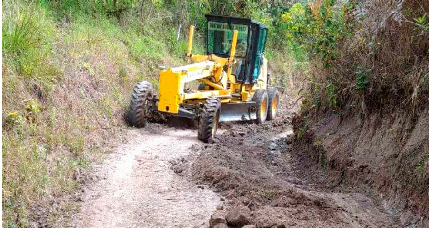
El alcalde Isauro Lozano Díaz argumentó falta de maquinaria
