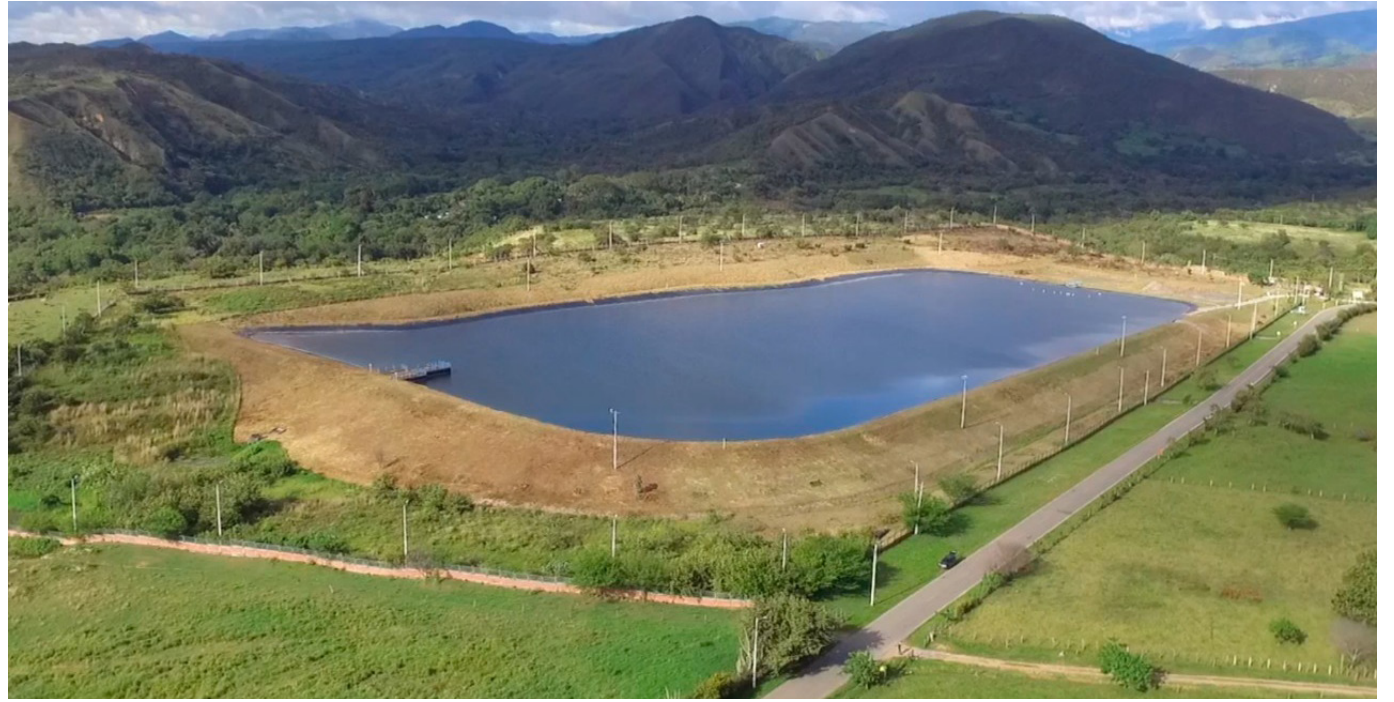
Hay una falla en el Reservoirio que no permite abastecer la bocatoma de El Tomo, con el caudal suficiente de agua, que la lleve a la Planta El Jardín.
