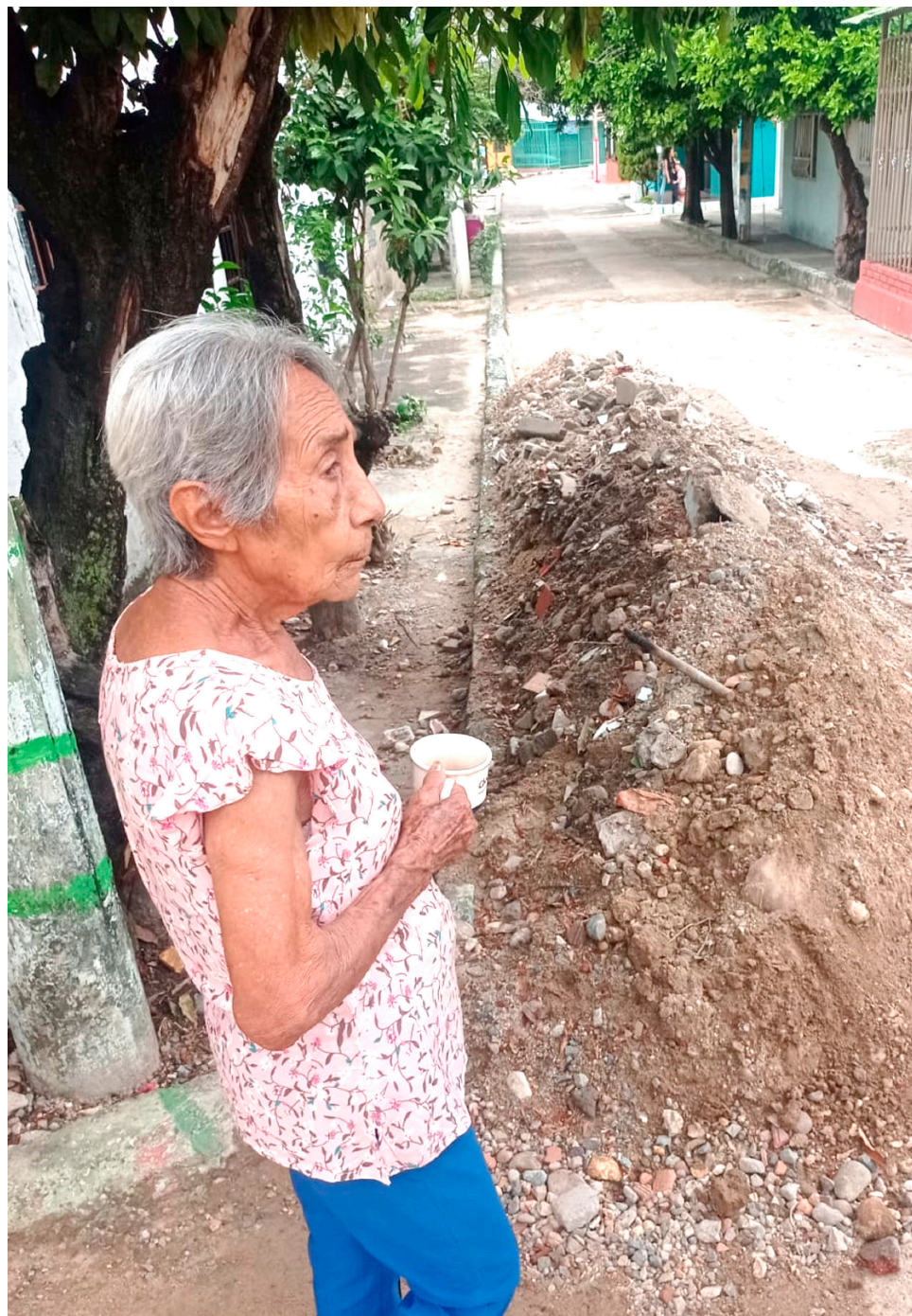
El levantamiento de la placa asfáltica dificulta que personas de la tercera edad puedan movilizarse.
