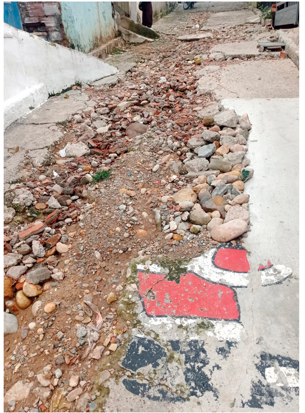
Las Ceibas realizó el reemplazo de la tubería de aguas lluvias en la sede Emayá de la Institución Educativa Agustín Codazzi, sin garantizar la respectiva pavimentación.
