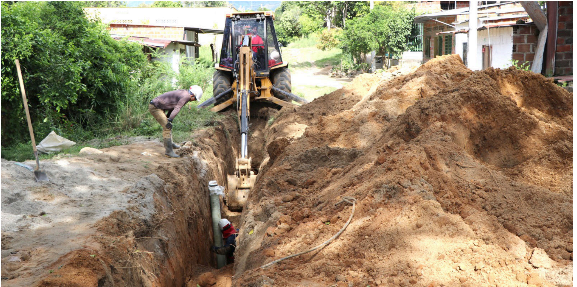
En La Orquídea, se instalarán 1.300 metros lineales de tubería de alcantarillado y 1.270 metros lineales de tubería de acueducto.
