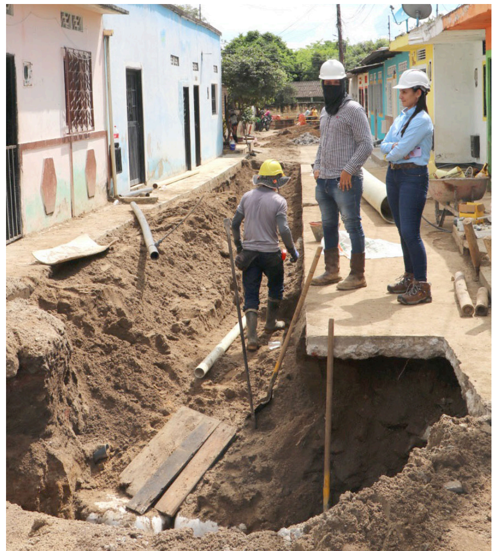
En el barrio El Gaitán, se instalarán 1.215 metros lineales de tubería de alcantarillado.
