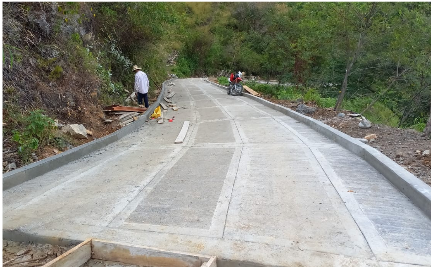
Los presidentes de Juntas de Acción Comunal de seis veredas de Timaná, están esperando desde hace tres meses el pago de los dineros luego de construir placa huellas. Aseguran que adeudan a proveedores y que no quieren ser sancionados.
