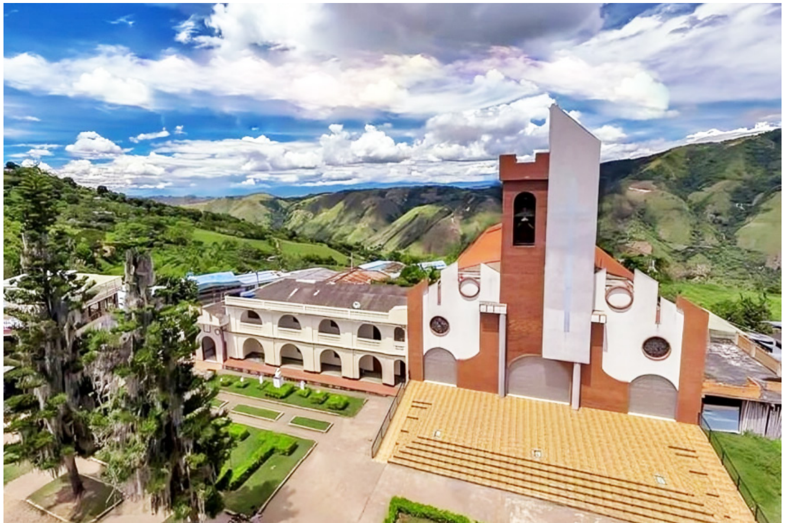
Carretera de acceso al municipio de Oporapa, será un cumplido.
