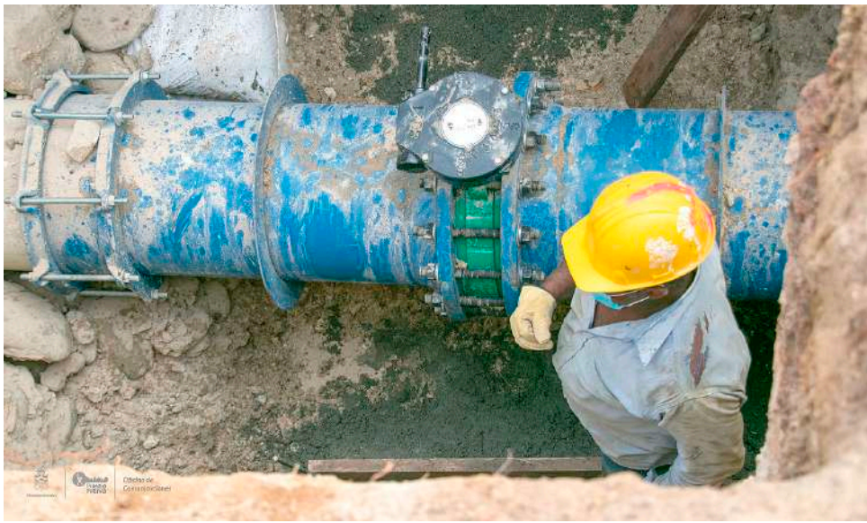
La obra busca solucionar la necesidad de infraestructura de saneamiento básico de la ciudadela Santa Clara, proyecto habitacional ubicada al sur de la ciudad.
