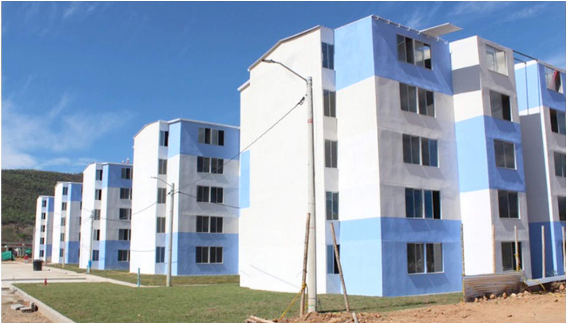
El Gobierno Departamental, apoyó la construcción vivienda en Palermo.
