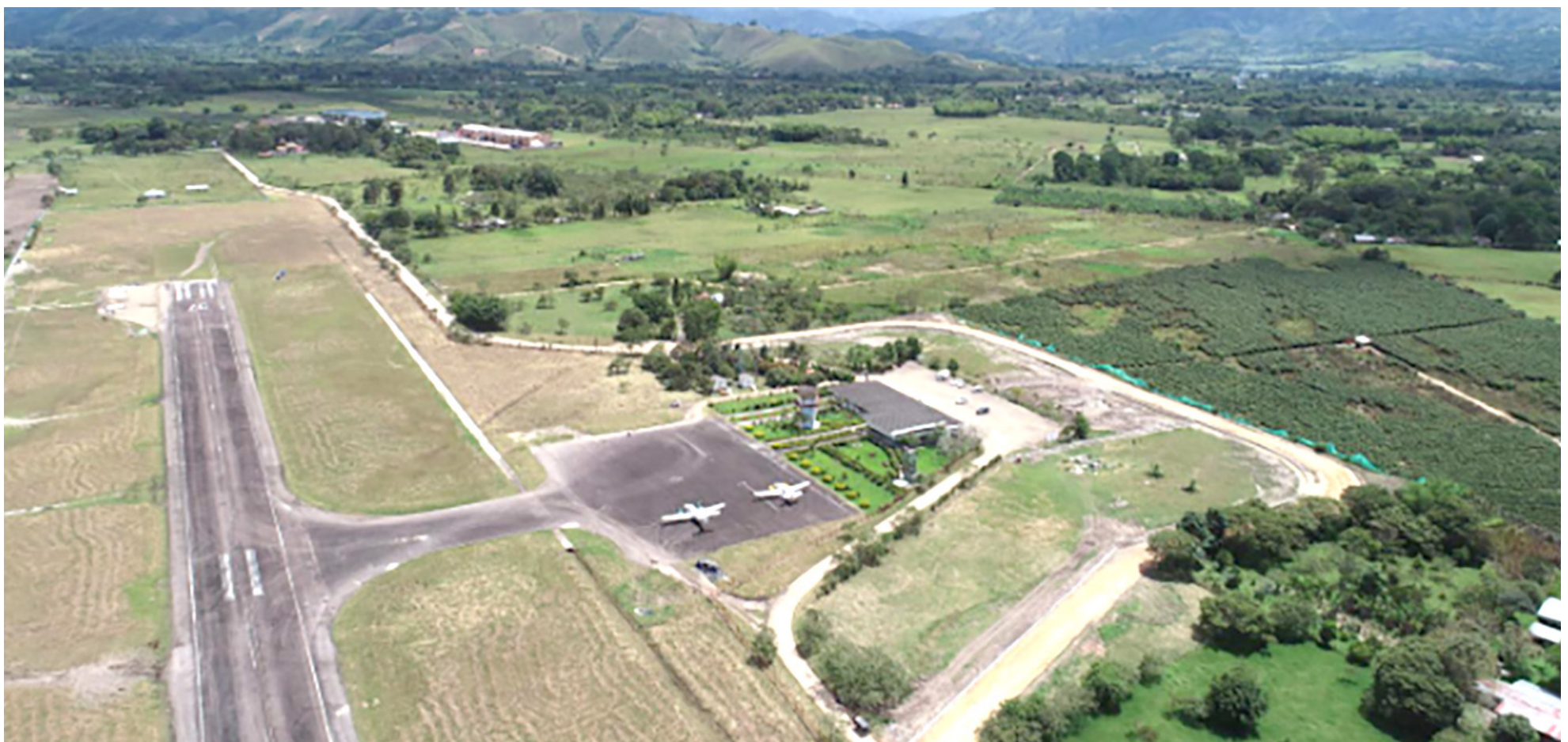
Una de las proyecciones es ampliar la pista de aterrizaje.
