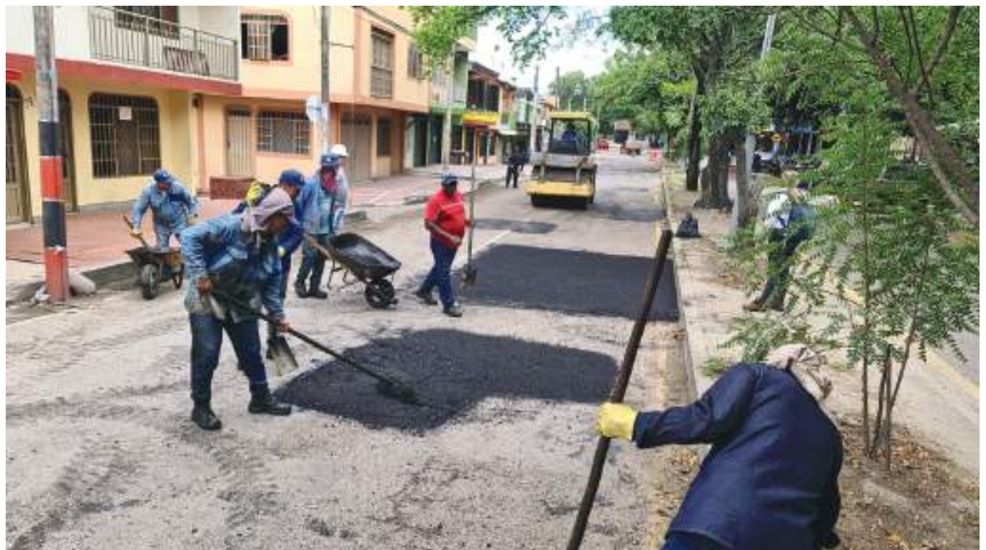
El director de Vías del Municipio, Aurelio Cubidez indicó que vienen trabajando en la capa asfáltica de la ciudad con los recursos asignados.
