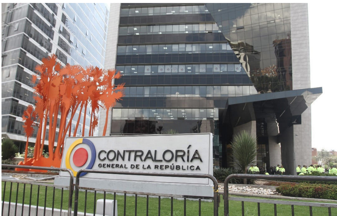
La Contraloría identificó deficiencias en la infraestructura física de cocinas y comedores escolares en el Huila, comprometiendo la adecuada prestación del servicio de alimentación escolar.
