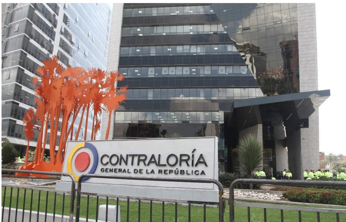
La Contraloría identificó deficiencias en la infraestructura física de cocinas y comedores escolares en el Huila, comprometiendo la adecuada prestación del servicio de alimentación escolar.
