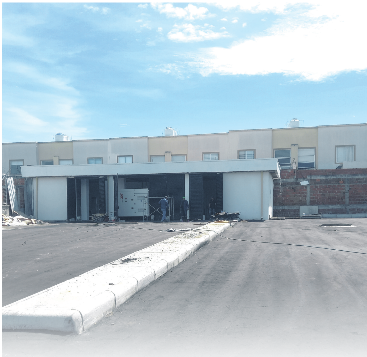
El área de los parqueaderos ya cuenta con la capa asfáltica y en los próximos días se realizará la demarcación.
