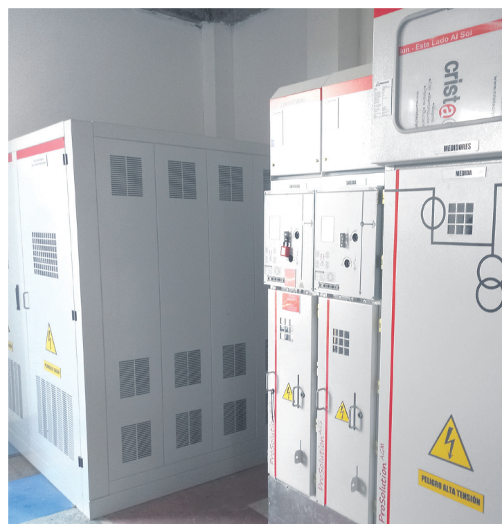
Los equipos eléctricos, aire acondicionado y del sistema de oxígeno que son vitales para que funcione como entidad de salud ya se están instalando.
