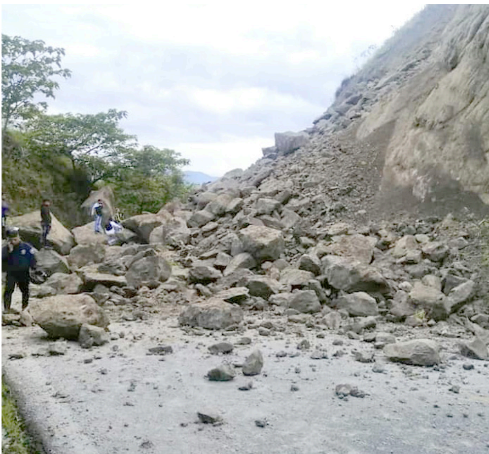
En Yaguará, se registró un deslizamiento provocando el cierre de la vía en el sector de Ventanas hacia Hobo
