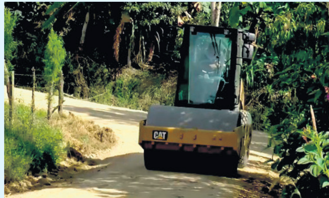
Tienen una motoniveladora, retroexcavadora, vibro compactador y una volqueta que está funcionando.
