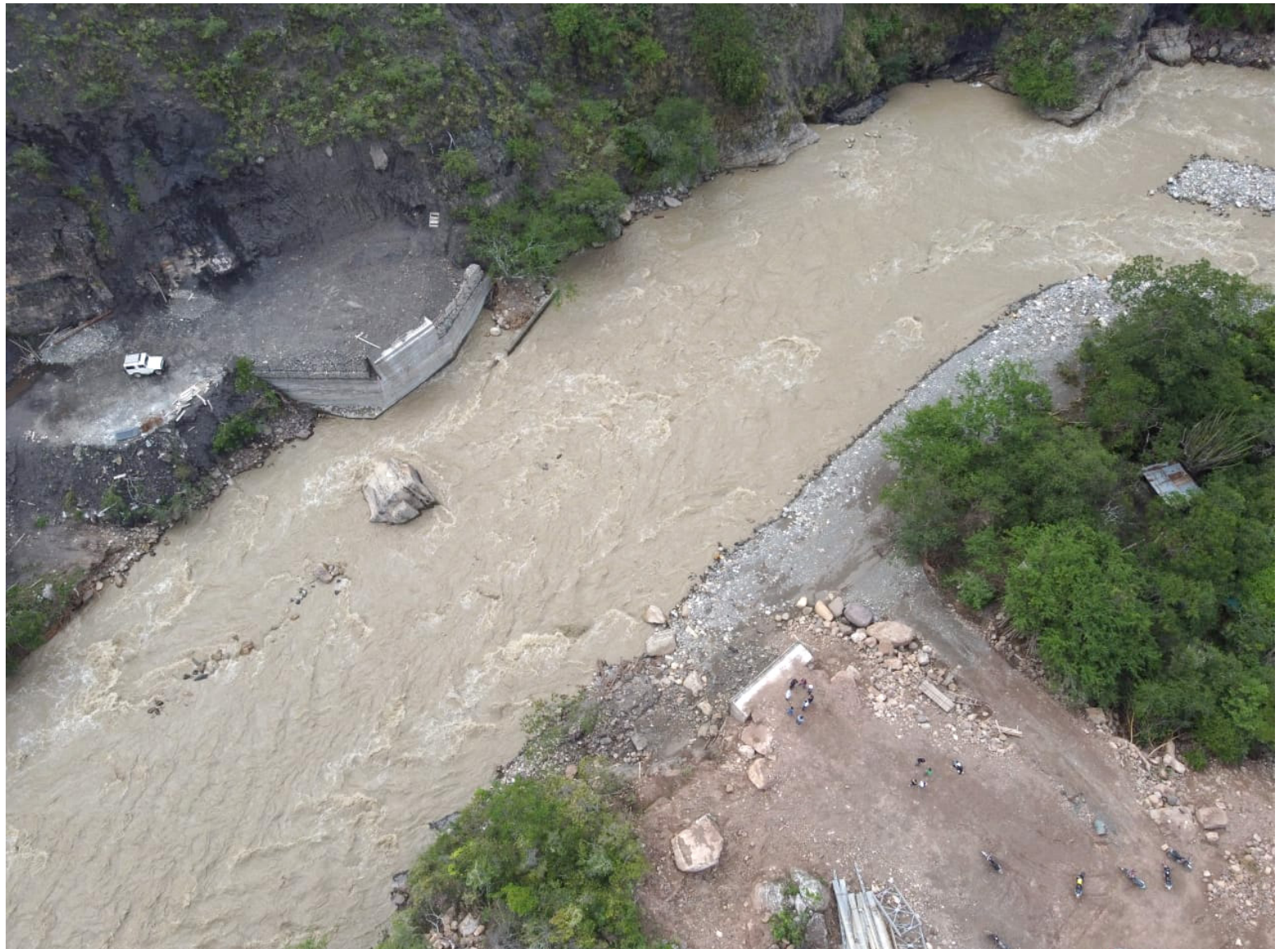
En este punto se va a instalar el puente La Unión.
