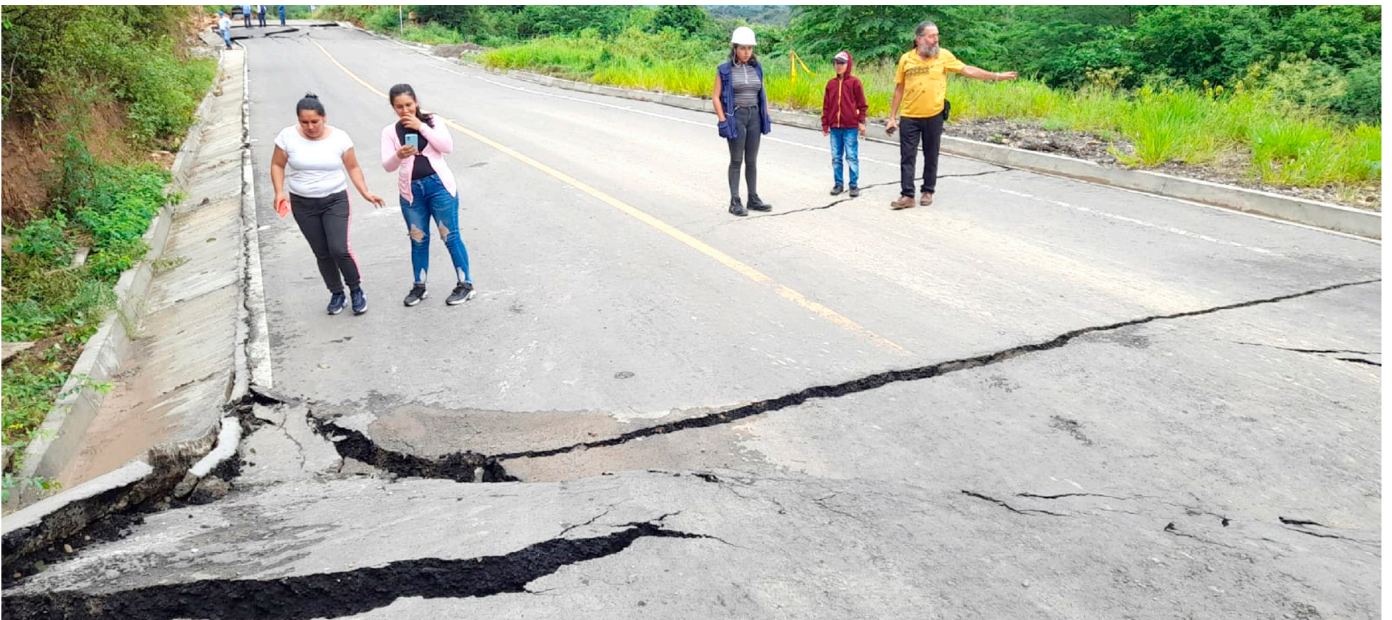
Cientos de familias se ven afectadas por el cierre de la vía, así sea parcial.
