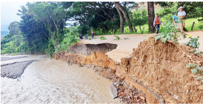
Obras en Santa María iniciarían a mitad de octubre
