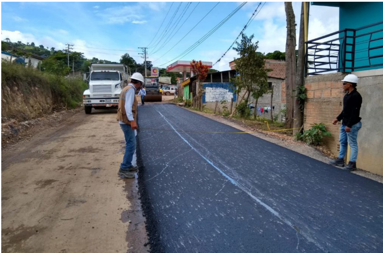
Proyectos como la pavimentación de la vía acceso Oporapa se encuentran en pausa debido a problemas legales y procesos de liquidación, según Luis Enrique Dussán, generando complicaciones para la ejecución de los contratos.
