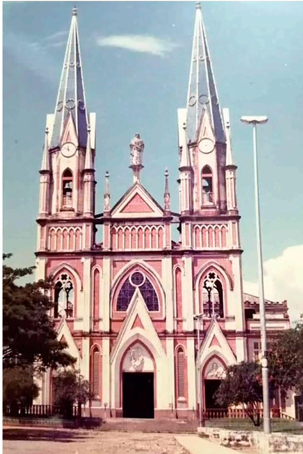
Templo de Yaguará construido con estilo neogótico.
