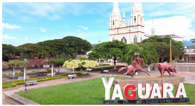
Templo en Yaguará necesita restauración
