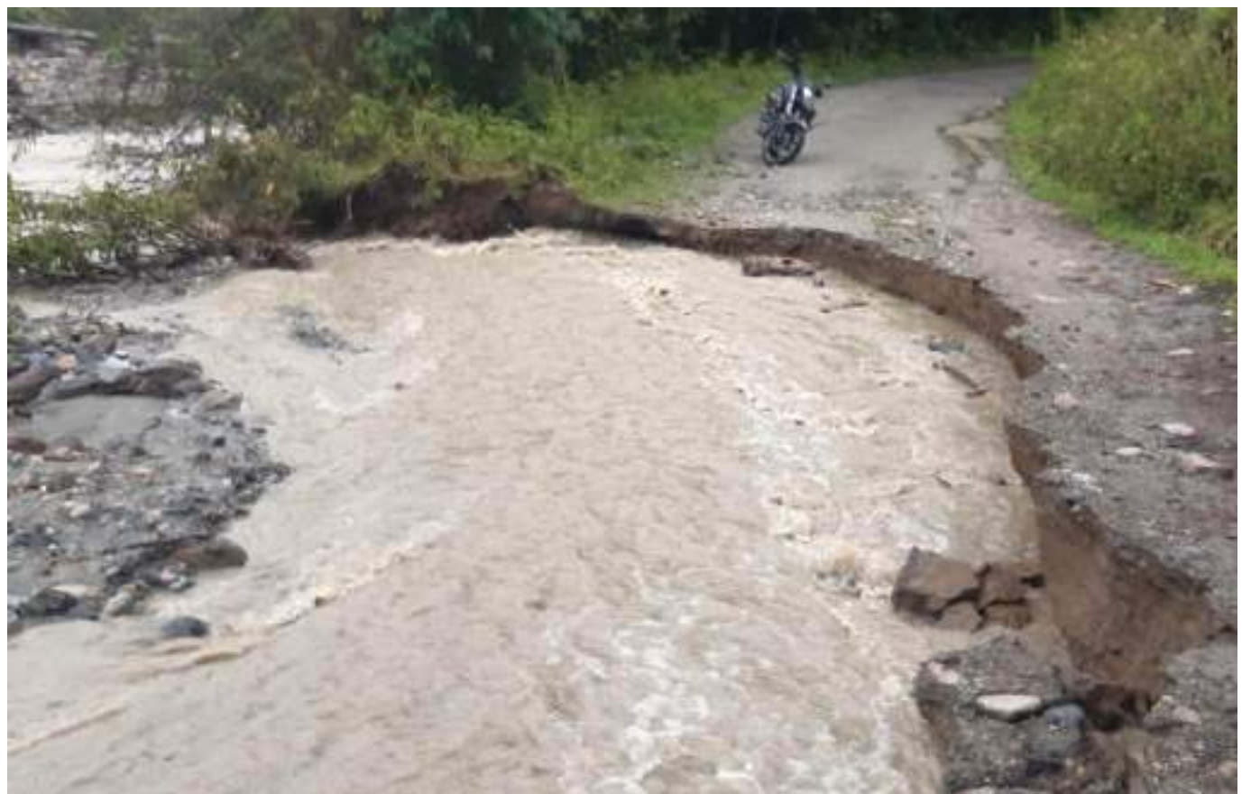
Desprendimiento de banca en zona rural de Paicol
