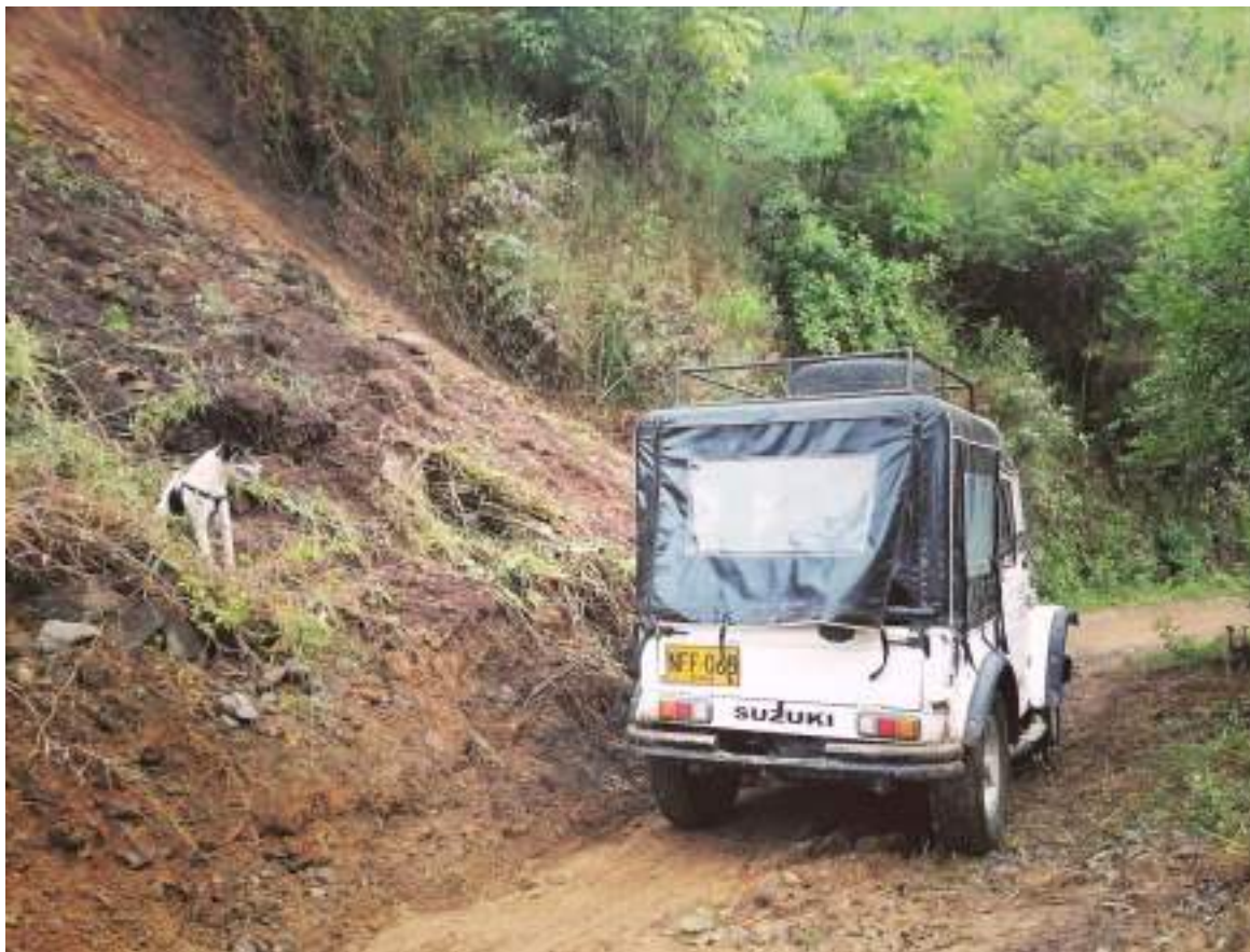
Zona rural de Santa María afectada por derrumbe.
