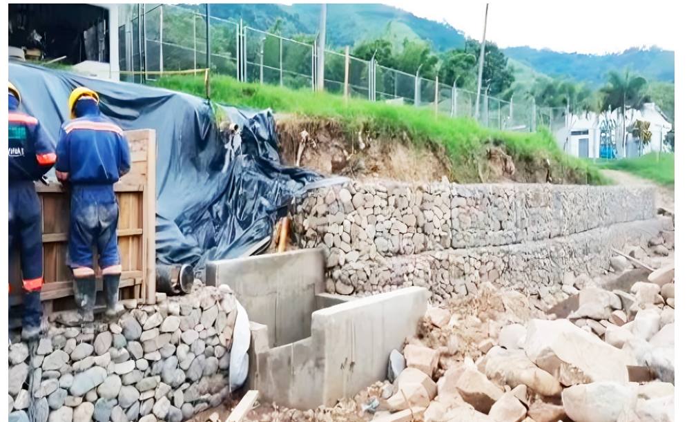
En términos de avance físico, la obra ha alcanzado un 47,70%, con una inversión de más de 17,871 millones de pesos.
