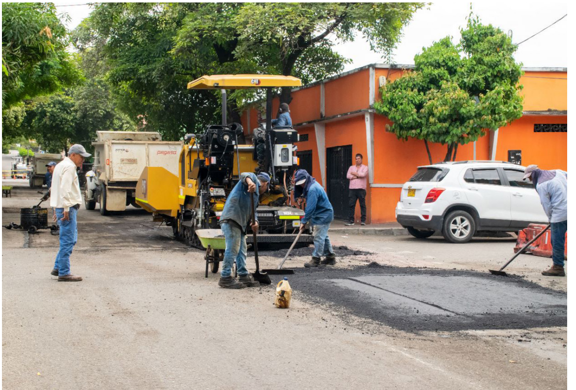
El inició del mejoramiento de la malla vial en Neiva, por parte de la Secretaría Vías e Infraestructuras. Las obras comenzaron en la Calle 15 entre Carrera 1 y 2.
