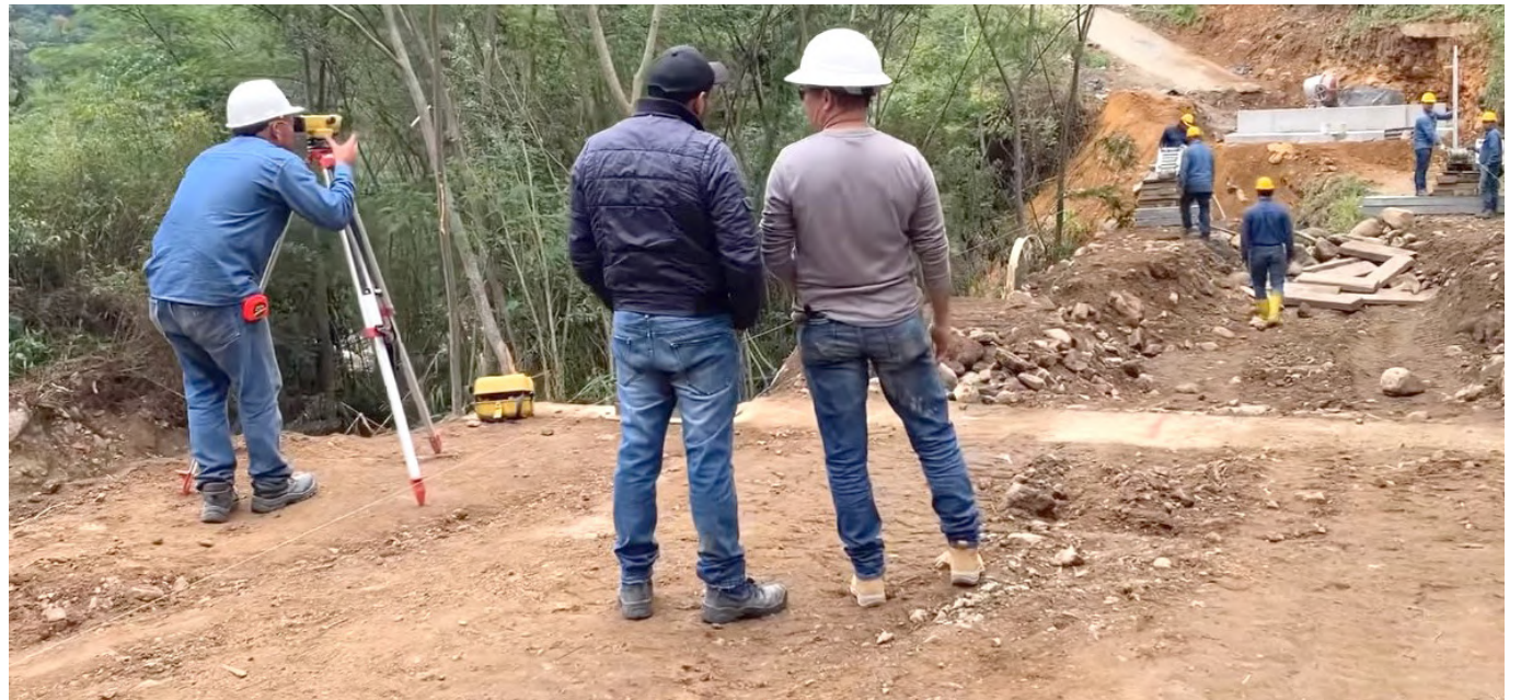
Puente en construcción en la vereda Quebradón Sur en Algeciras.
