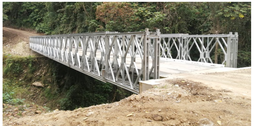
Puente ya instalado en el sector rural de Algeciras.
