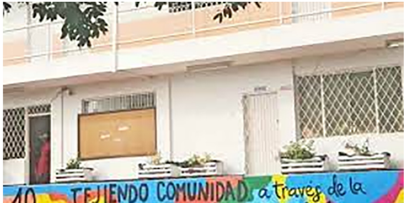
La Escuela Claretiana, mejorará sus instalaciones.
