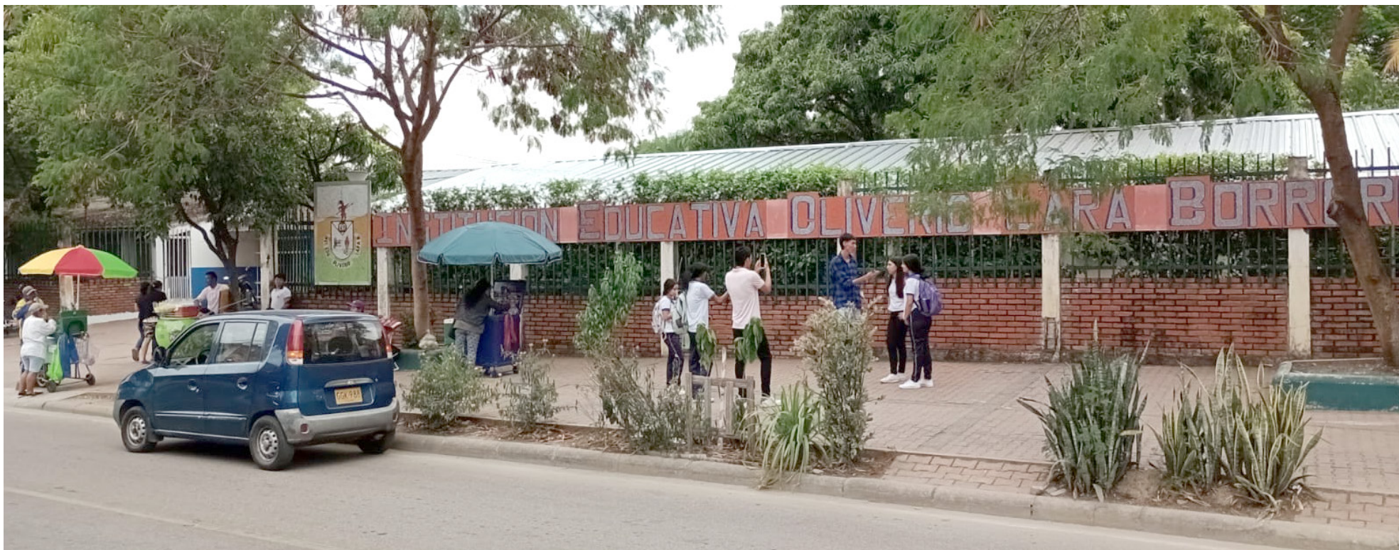
Colegio Oliverio Lara, tendrá que hacer adecuaciones.
