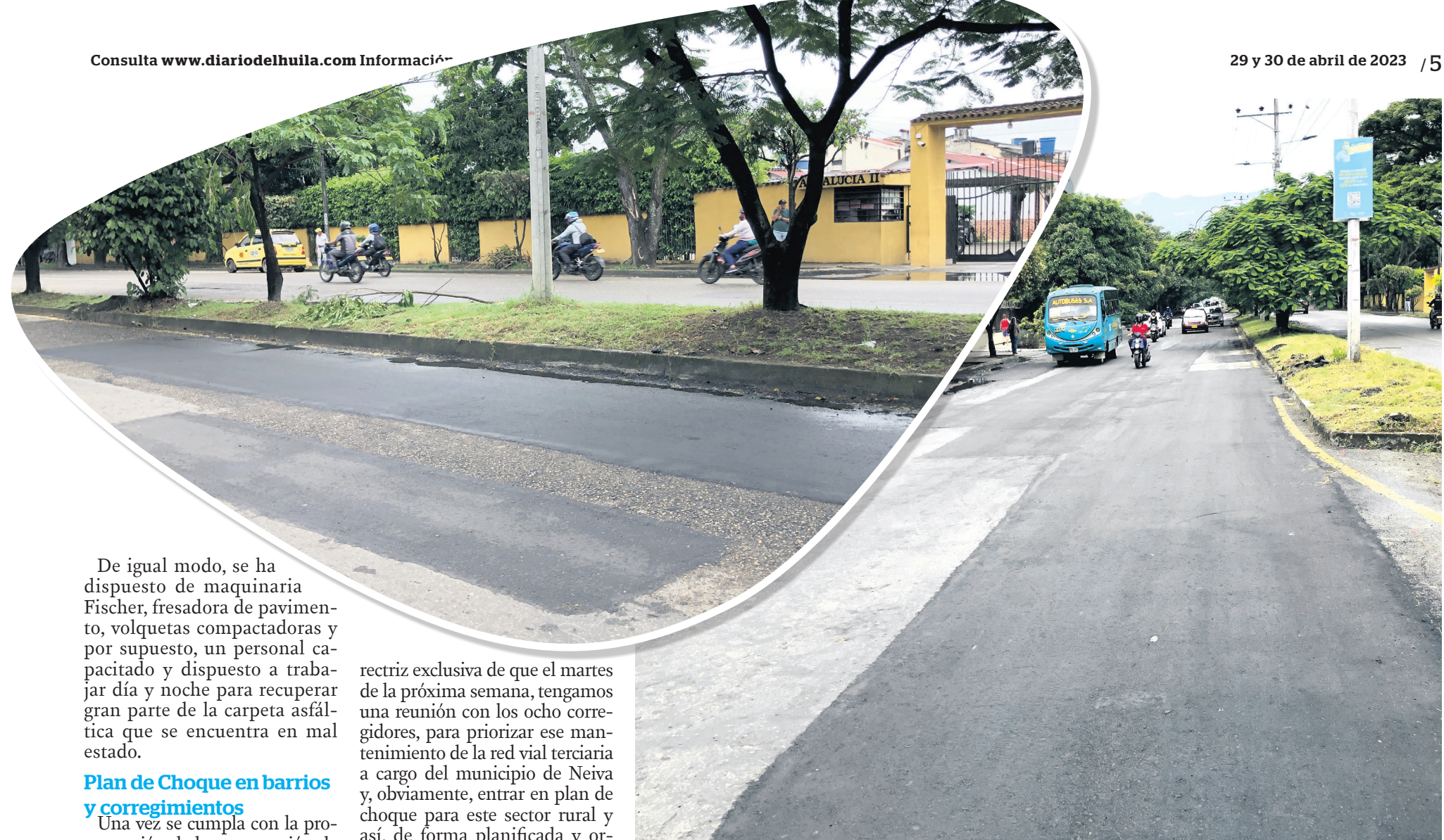
Pavimentación terminada en la Carrera 11 No 6-14 - 42 - 68, Sector Los Arrayanes, frente al conjunto Andalucía.
