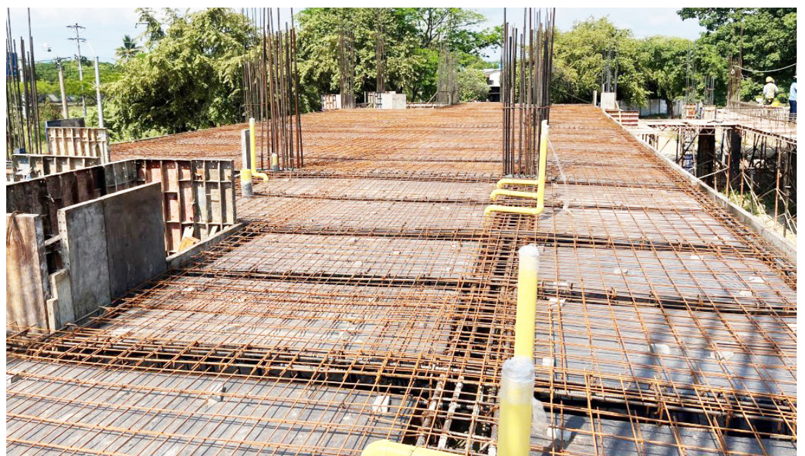
El ejecutor ha decidido hacer el bloque de aulas medias hasta el segundo piso con una plancha de concreto y sin cubierta.
