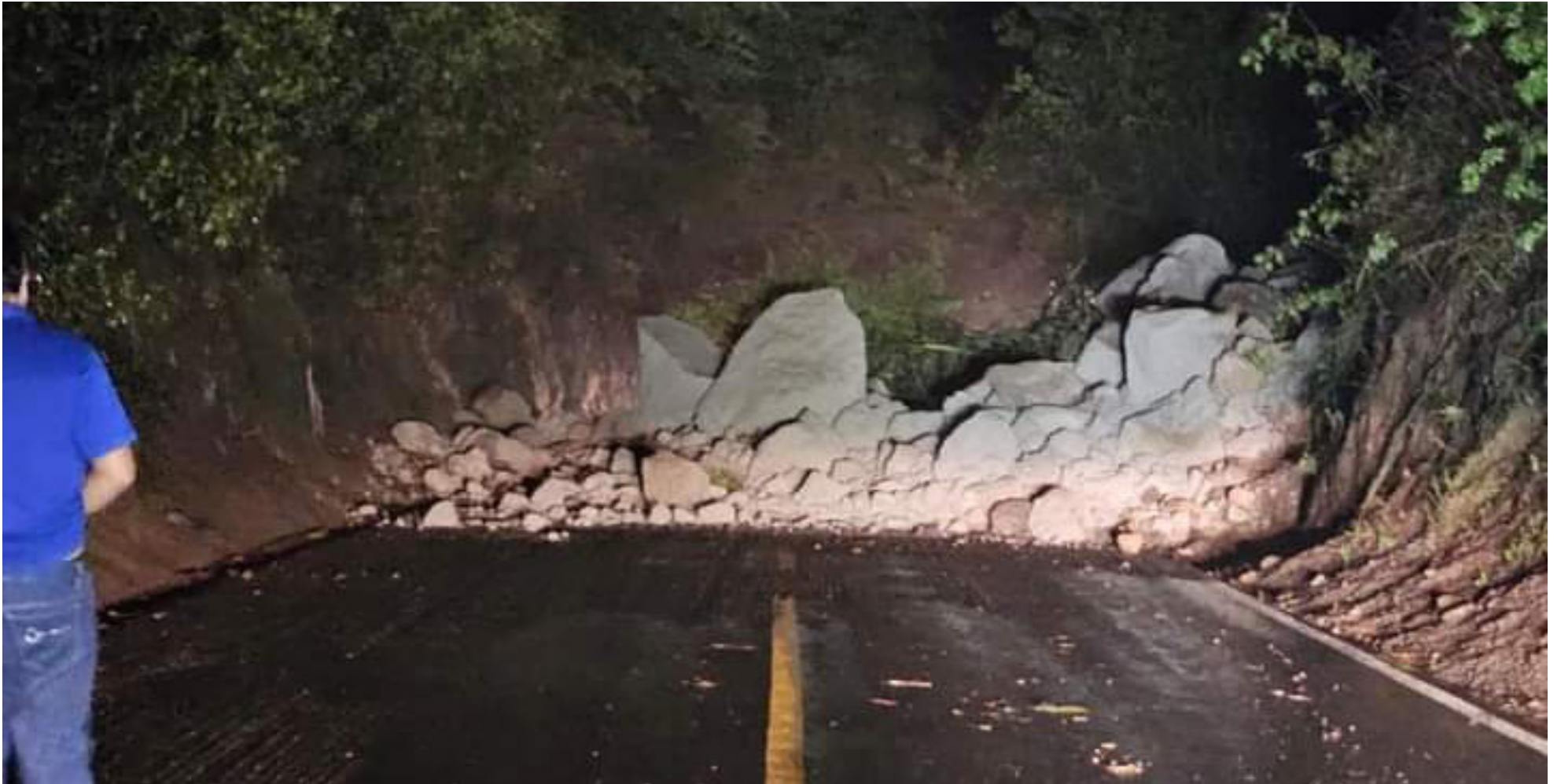
En la vía entre Garzón y la Jagua, se presentó un deslizamiento.
