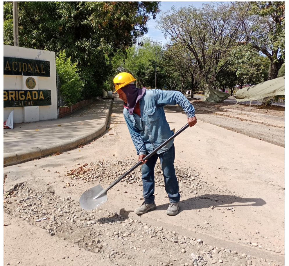
La obra busca acabar con la inundación que se presentaba.
