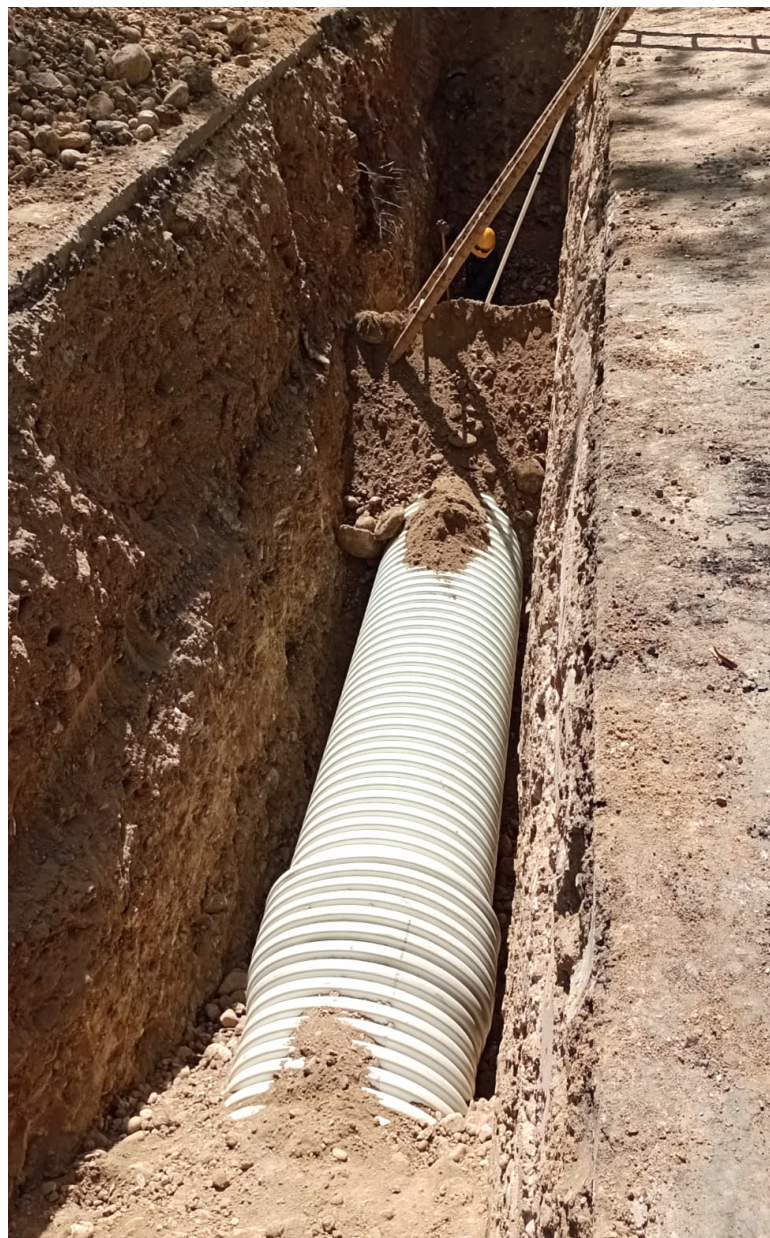
La tubería va a conducir el agua lluvia al río.
