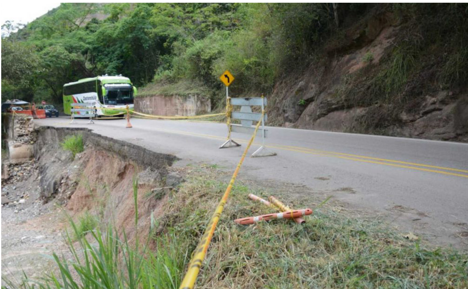
5. El nuevo proyecto vial, ayudaría al tráfico vehicular en caso del cierre de la ‘Ruta 45’.
