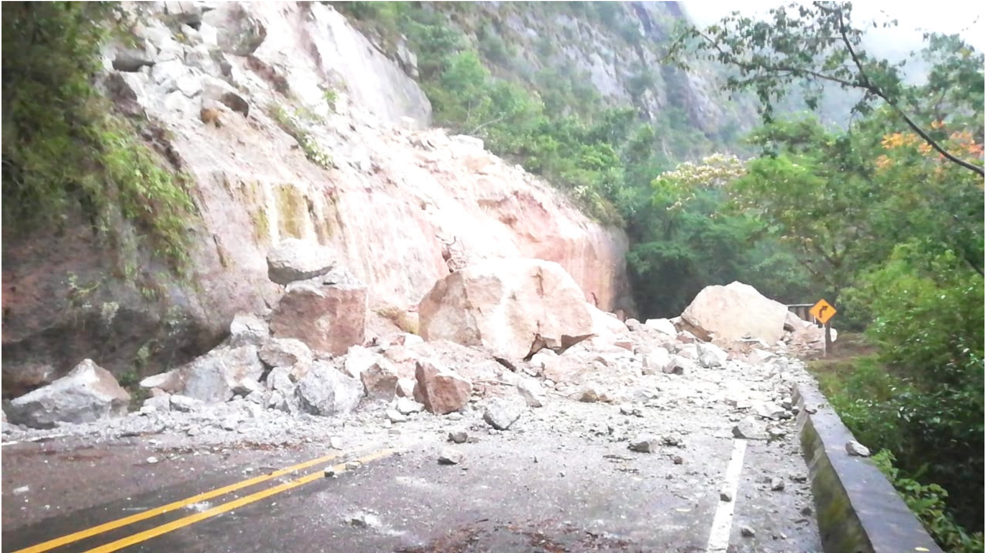
Estudios detallan una falla presente en el macizo rocoso fracturado, que corresponde a la caída de rocas y volcamiento de bloques.
