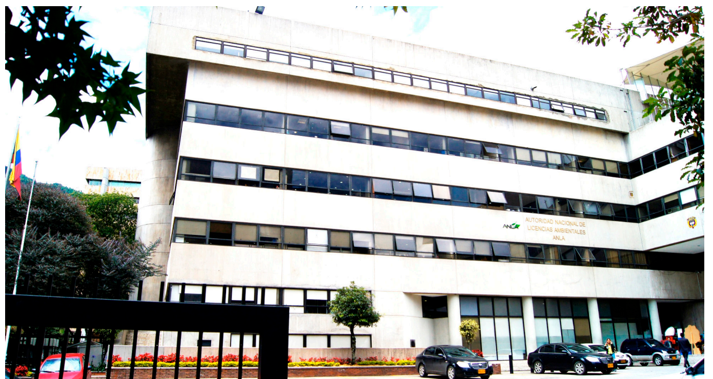
Actualmente la Concesionaria Ruta 45 está a la espera de la vía libre del Ministerio de Ambiente para iniciar las obras.
