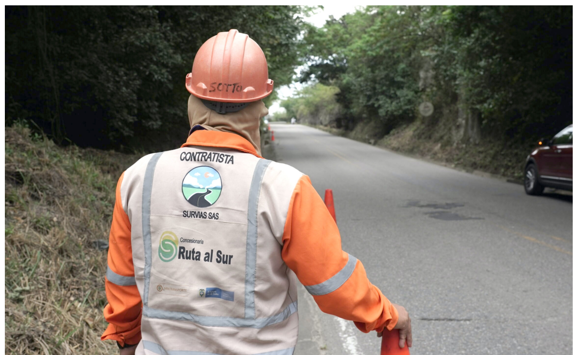
Por el momento, y durante el tiempo que se demore el inicio y culminación de obras en Pericongo, se solicita atención especial a los llamados de las autoridades.
