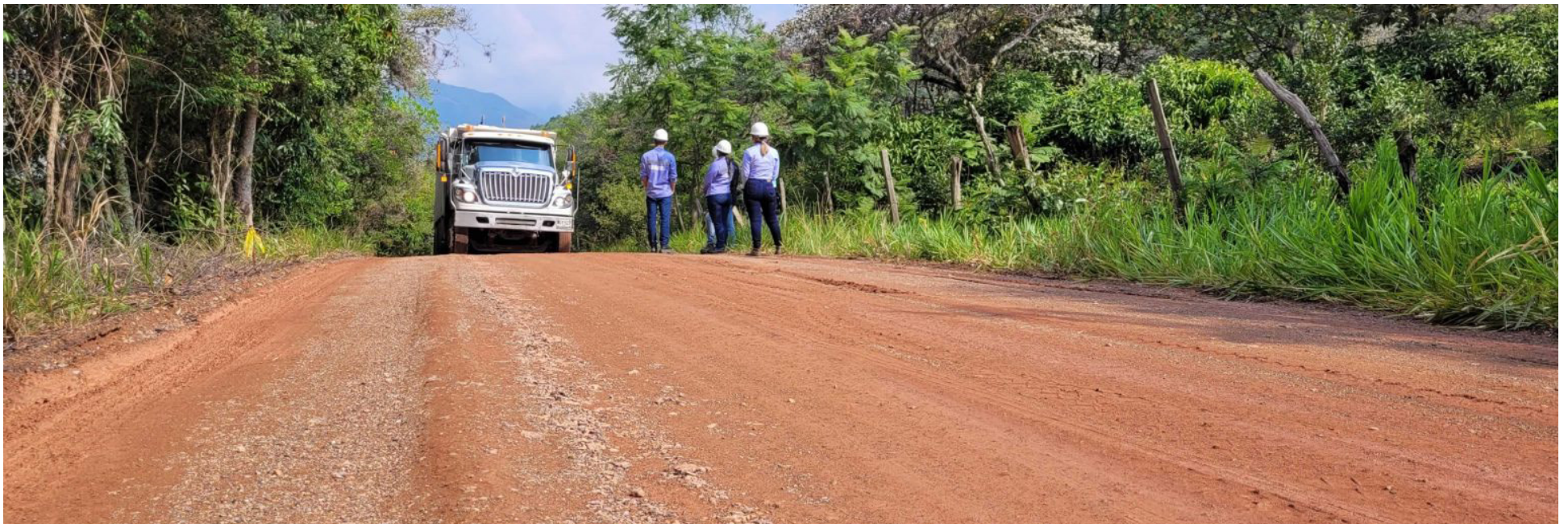
La vía principal hacia Íquira, va a ser arreglada.
