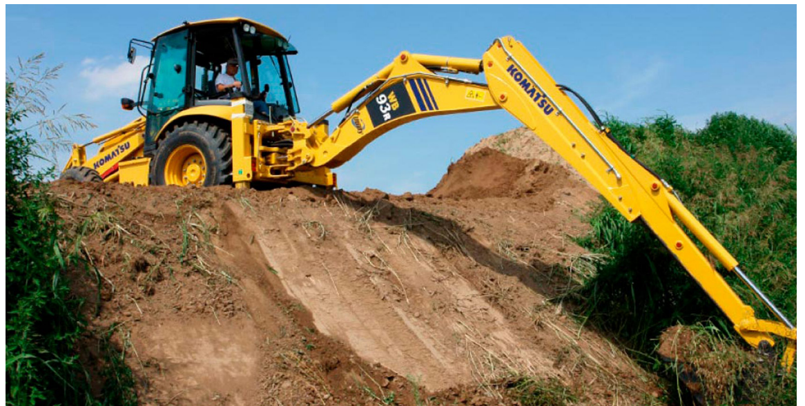
Buscan tener ‘maquinaria amarilla’, para arreglar de manera ágil las vías.
