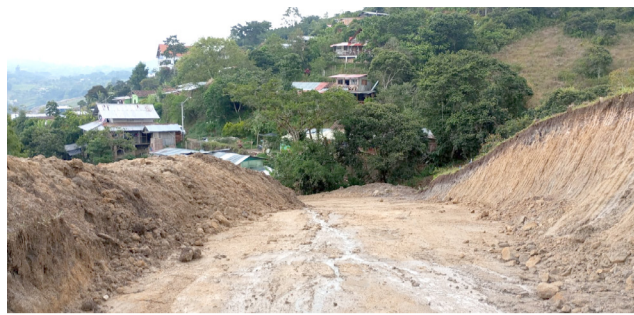
Habitantes de San Agustín se quejan por construcción de vía
