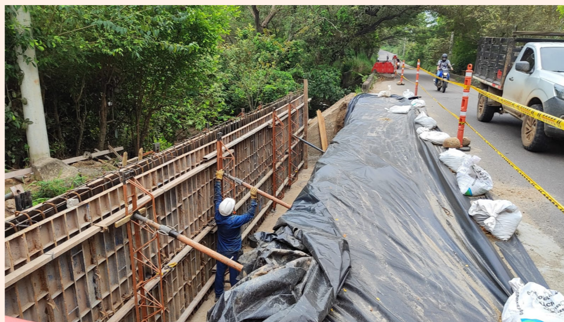
Las obras cuentan con una importante inversión.
