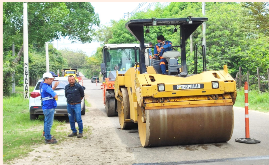
Actualmente la maquinaria se encuentra en la zona avanzando en la intervención.
