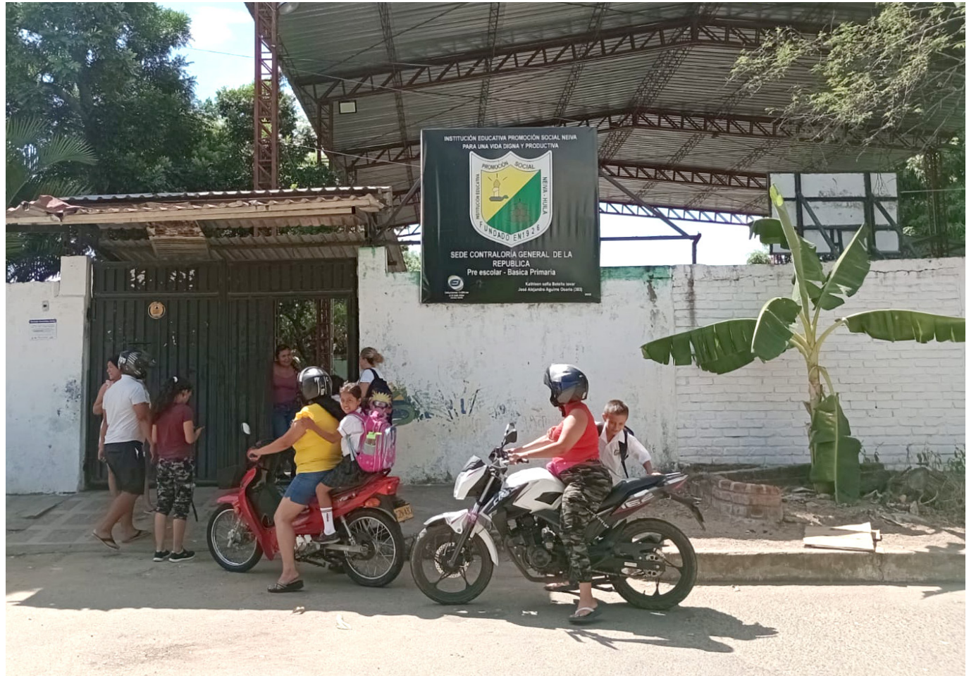
Escuela sede Contraloría General de la República, afectada.
