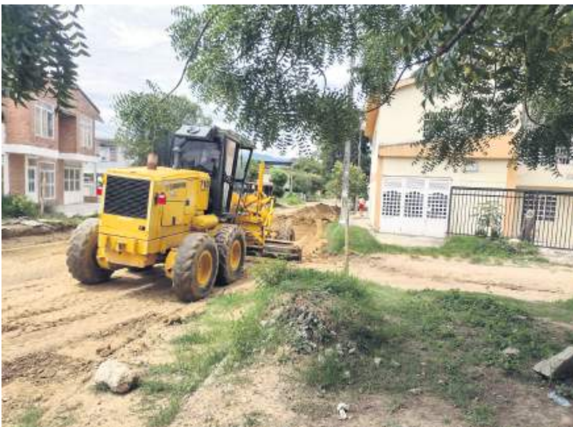
La vía se interviene con maquinaria pesada.
