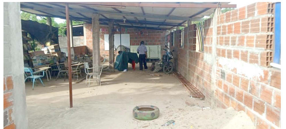
En el asentamiento Lomas de San Pedro, la comunidad logró levantar las paredes de lo que será una escuela. Hoy por iniciativa de cinco jóvenes neivanos, anhelan ponerle el techo.
