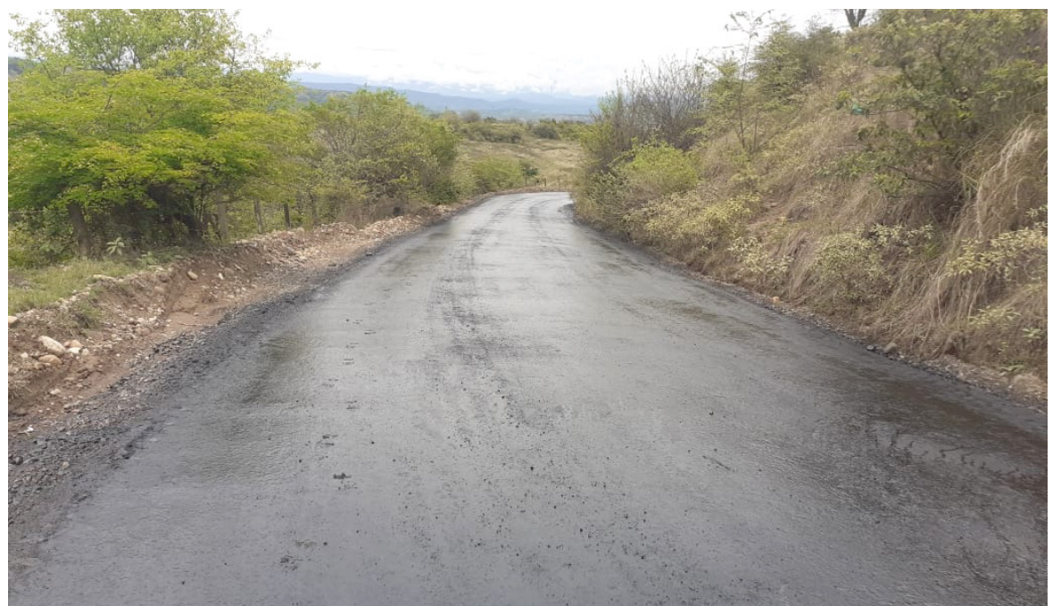
Así quedó la nueva vía.
