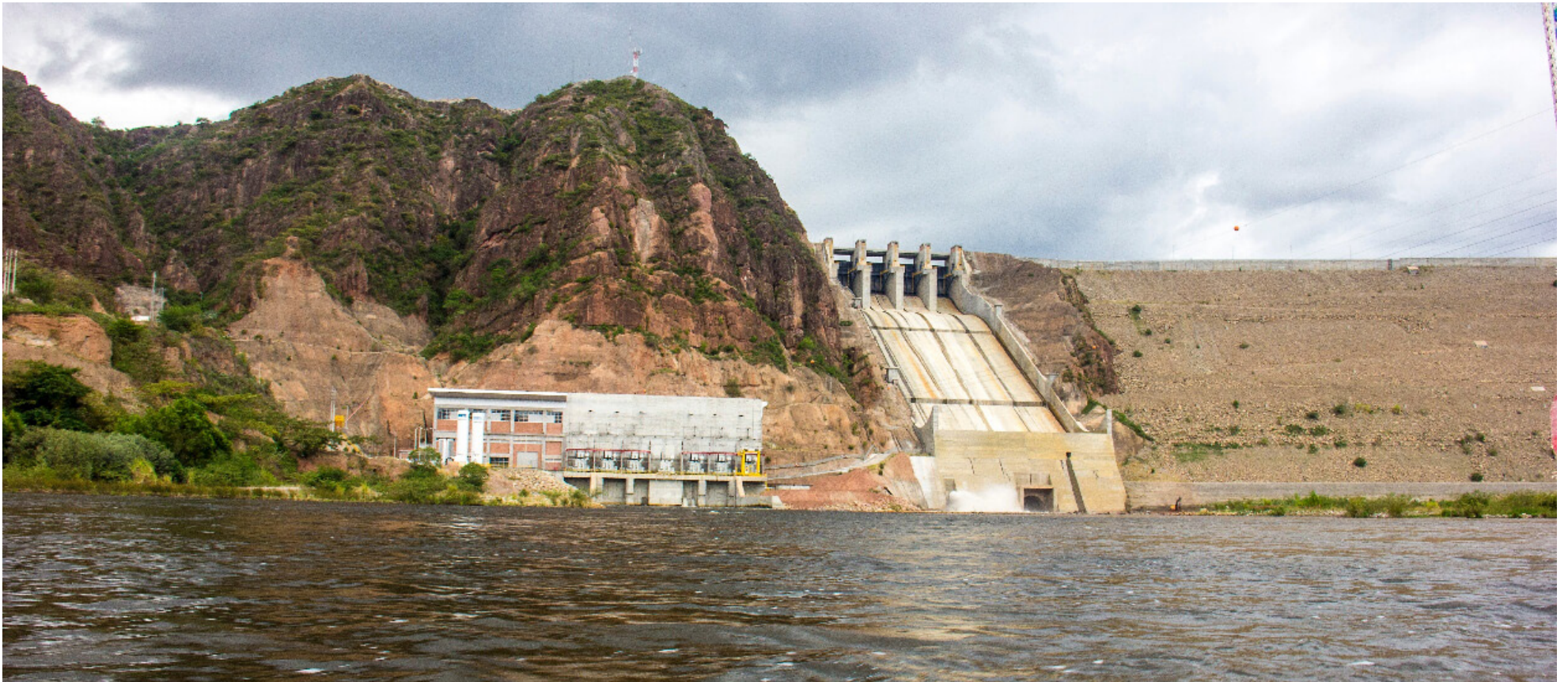
Las obras, se dan como compensación por la construcción de la Hidroeléctrica el Quimbo.
