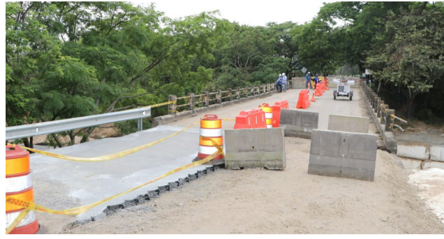
Terrenos tienen 'enredadas' obras de la Ruta 45
