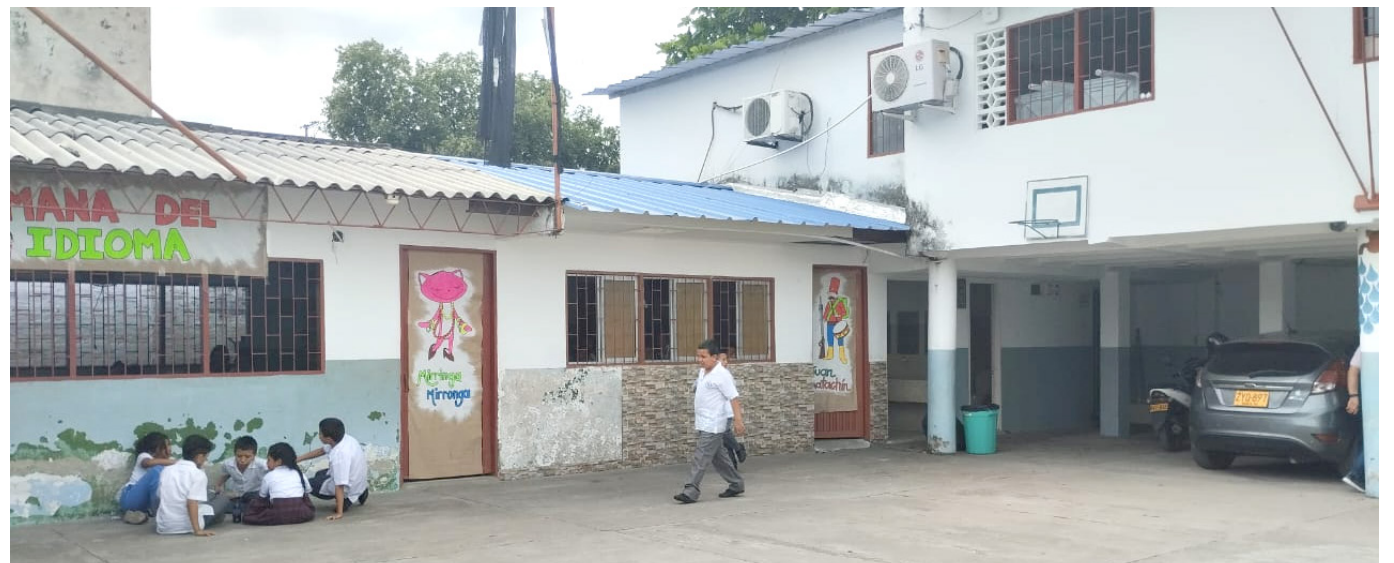
La falta de cubiertas o encerramiento y la asignación de personal para la vigilancia afecta la seguridad de las sedes.
