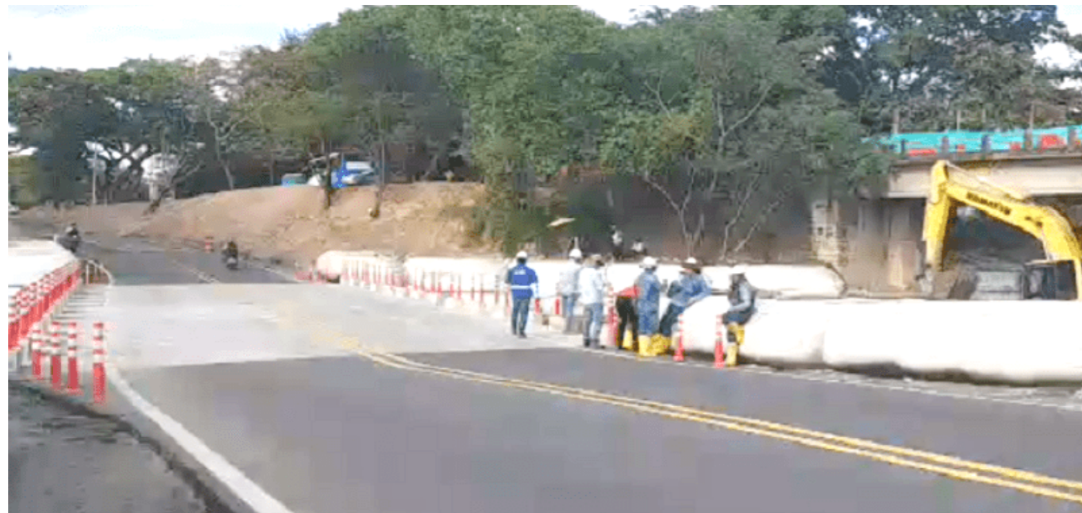
La apertura del puente de arenoso el sábado facilitó la movilidad hacia el sur del Huila.
