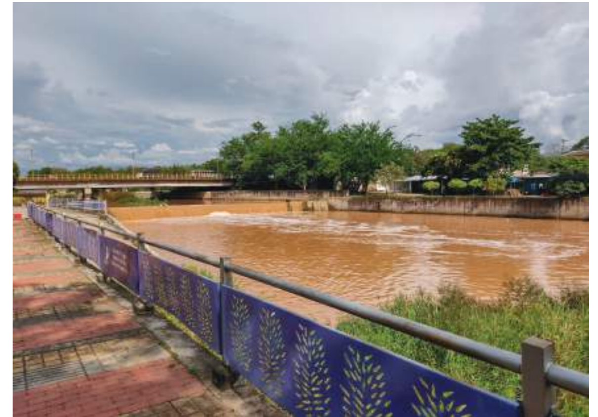
La canalización del río las ceibas se observan en uno de los costados.
