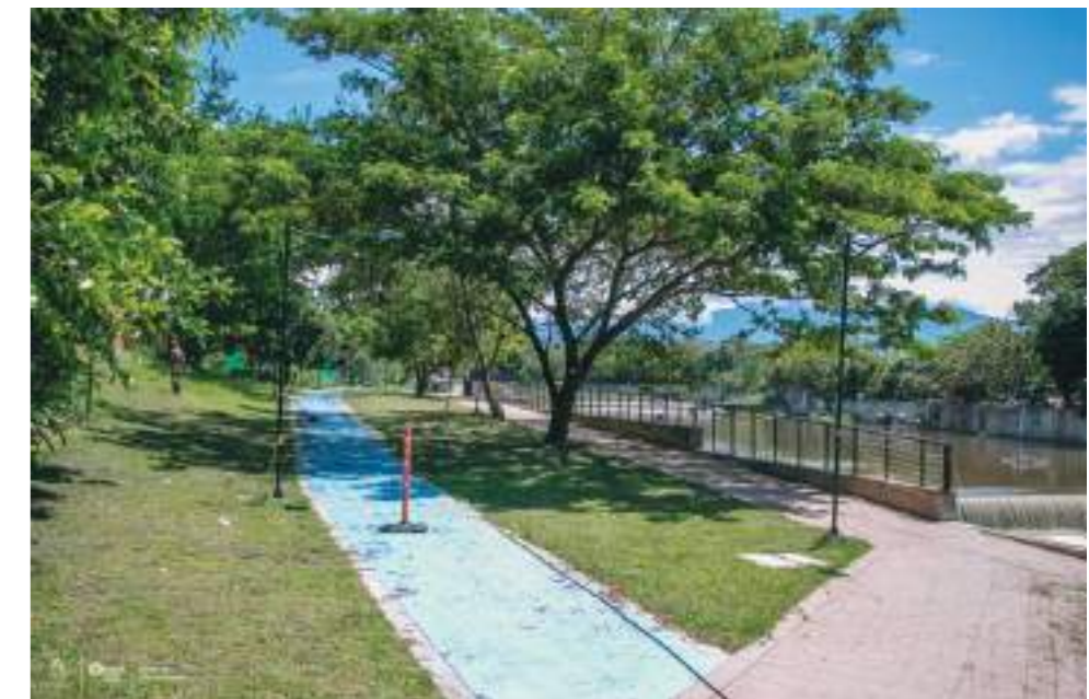
Las obras incluyen sendero peatonal y ciclorruta.
